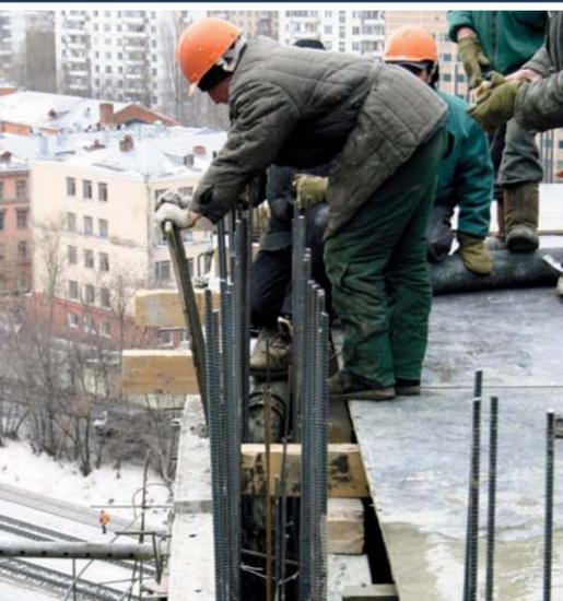
Заливка бетона в опалубку
