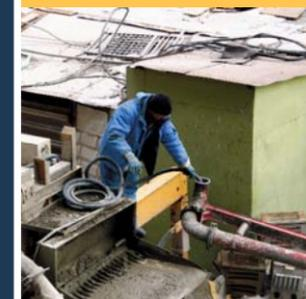
Промывка бетоновода. Закачиваем воду
