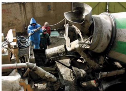
Подача бетона из автобетоновоза. Оператор перекачивает воду
